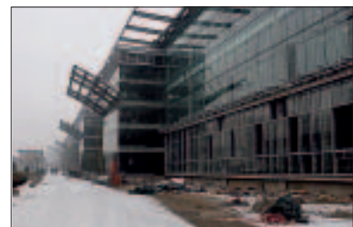
Anlagefront im Rohbau
